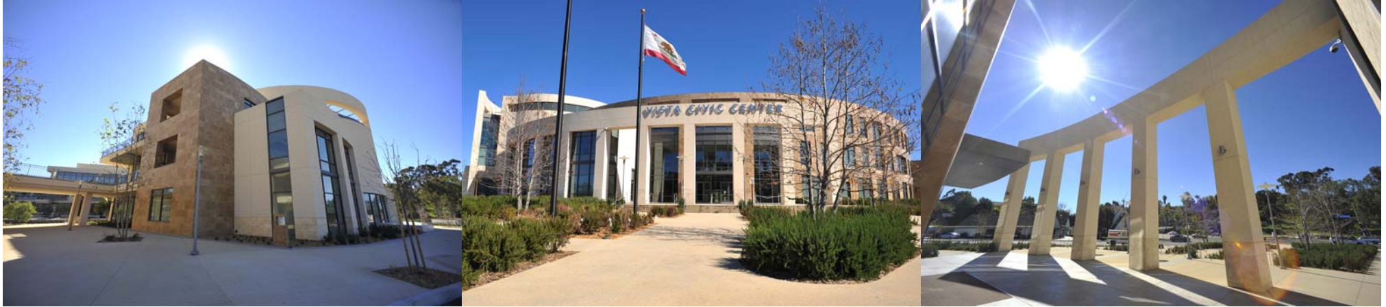
Vista Civic Center – Vista, CA
